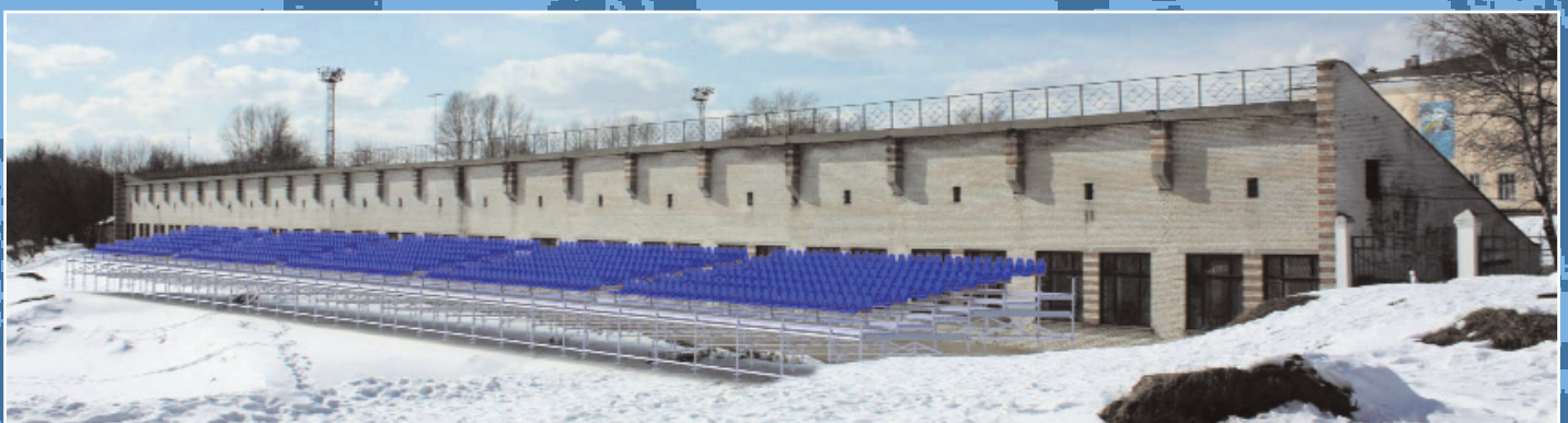
Временные трибуны арены мотокросса. Стадион Торпедо, г. Люберцы.
