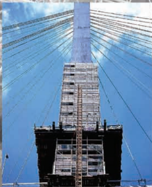
Опорные леса для мостов (Doka-Staxo-system)
