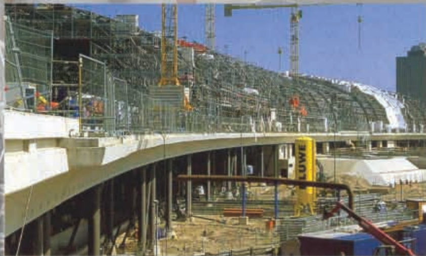
Опорные леса для мостов (Doka-Staxo-system)
