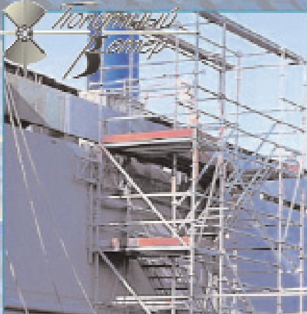
**Использование лестниц:** обеспечивает более безопасный и простой доступ на различные уровни лесов без необходимости входить на рабочую зону. Лестницы входят в стандартный набор. Так же имеются лестничные башни с нагрузкой 7,5 Кн/м<sup>2</sup>.
