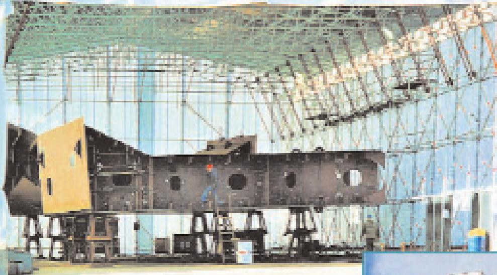
Кассетная Крыша, системы Keder и Protect, позволяют не прерывать работу даже при плохих погодных условиях, благодаря чему будет четко соблюдаться график работ.
