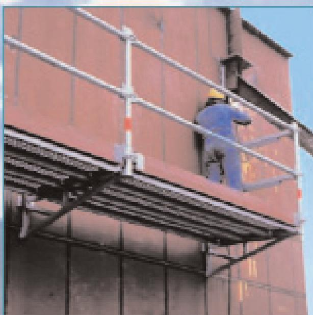
**Консоли:** Самый простой и быстрый способ установить системы на нужной высоте для строительных и ремонтных работ.
